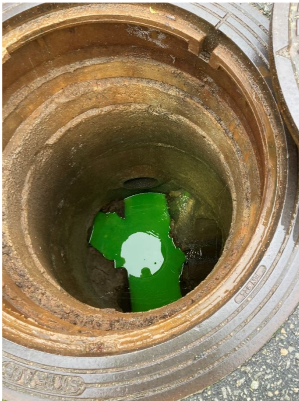
Spårning av felaktigt anslutet tillskottsvatten med metoden Färgning.
