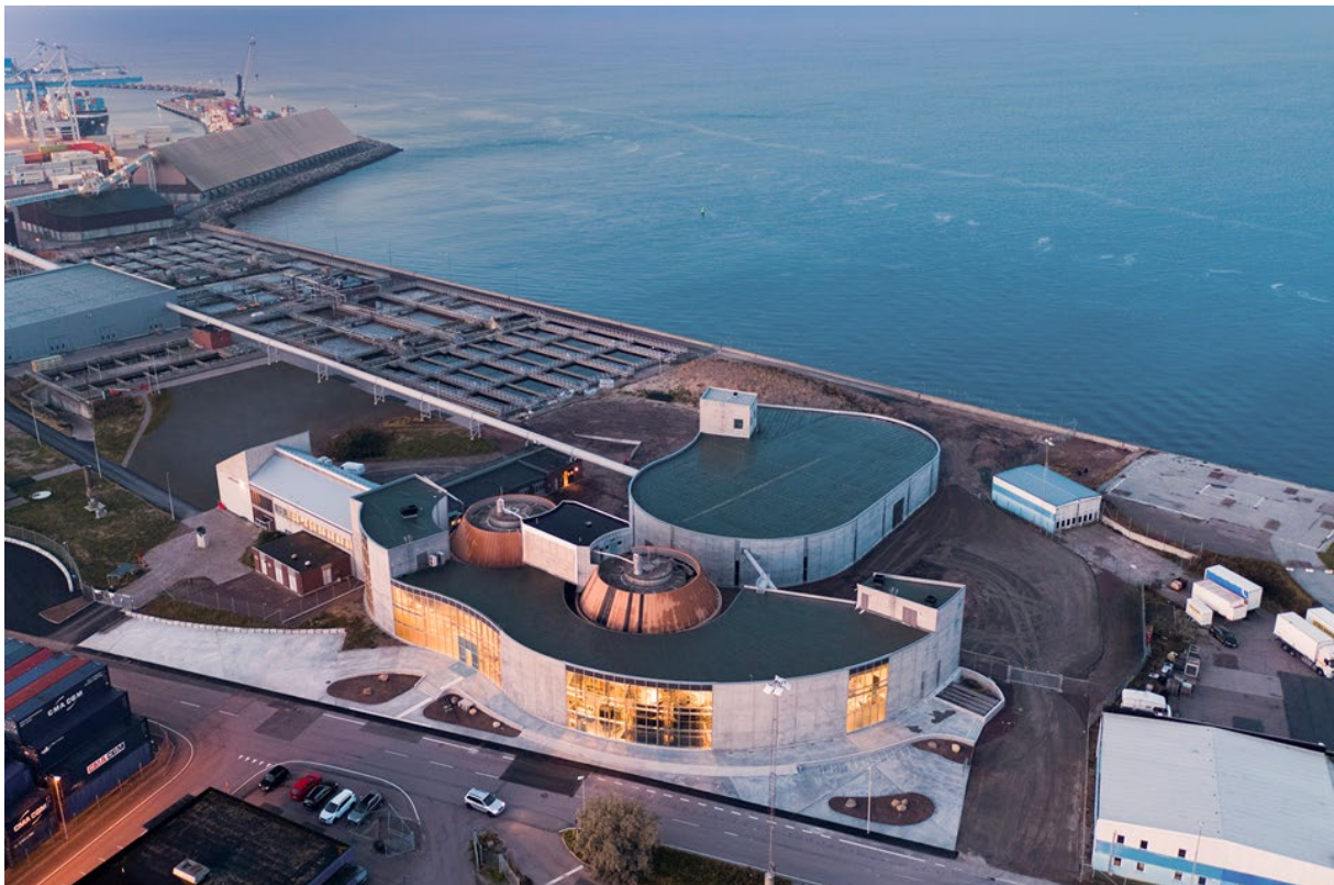
Den nybyggda utvecklingsanläggningen RecoLab belägen på Öresundsverket i Helsingborg. (Foto: NSVA).
