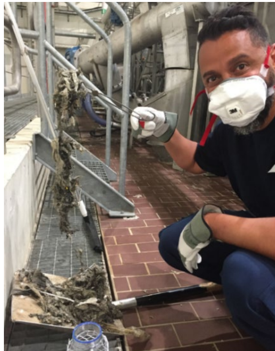
Sadi Hadi tar prov på rens på Ryaverket. (Foto: Svenskt Vatten)
