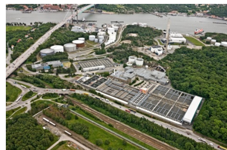
Ryaverket vid Göta älv i Göteborg. Foto: Bergslagsbild
