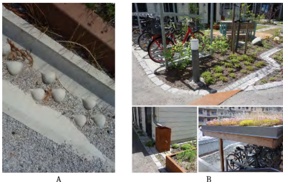
Figur 11: Tre exempel på dagvattensystemet i Brunnsnäs. Vid besöket var få delar färdigställda, men bilderna i B kommer från en helt färdigställd innergård.
