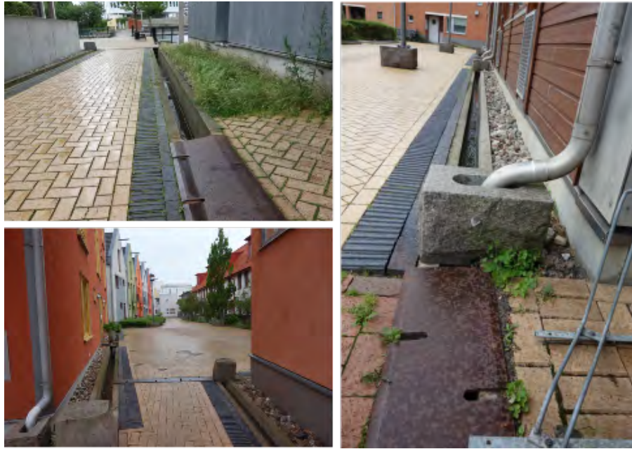
Figur 8: Detaljbilder från dagvattenssystemet i Västra Hamnen.
