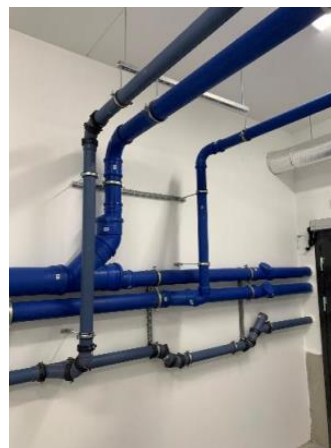
Dragnings av Tre rör ut i fastighet i Oceanhamnen i Helsingborg.
