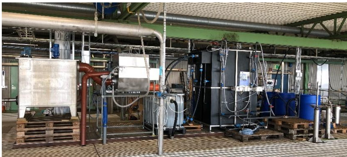
Pilotanläggning med flockning-fällning, trumfilter, membran och granulerat aktivt kol på Svedala avloppsreningsverk.
