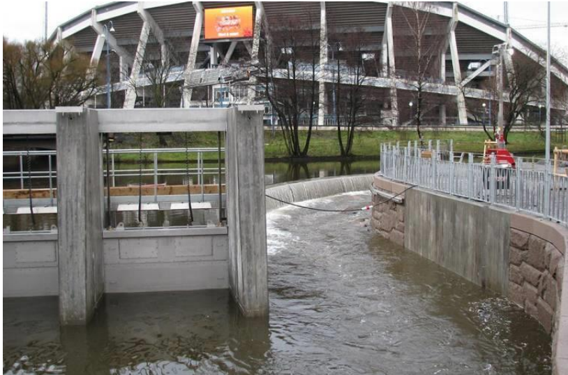
Figur 3. Dämnet vid Mölndalsån.
