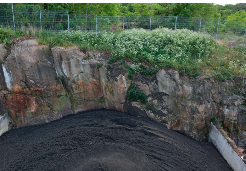
Utsläpp av metan till luften från ett slamlager blir mindre om två röt-kammare drivs i serie i stället för parallellt (foto: Ann Mattsson).
