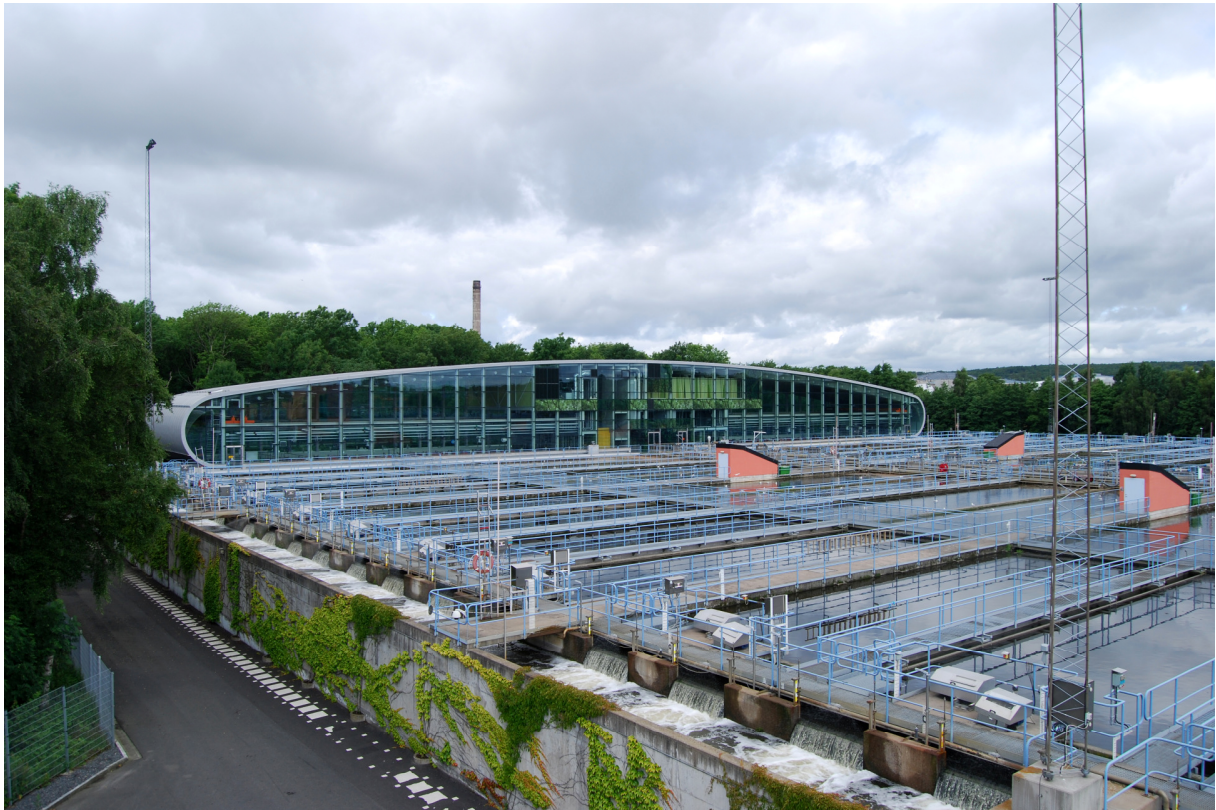
Sedimenteringsbassänger och skivfilteranläggning på Ryaverket i Göteborg. Foto: Ulrika Wahlström (2012)
