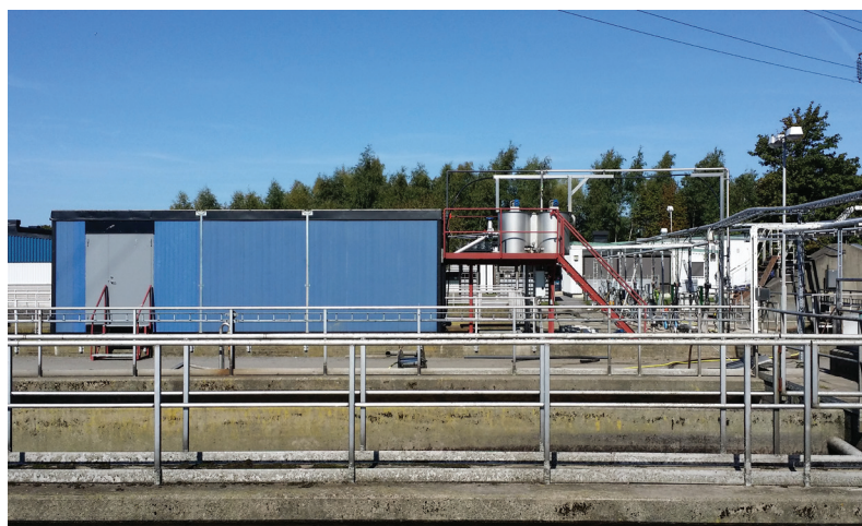
Pilotanläggningen på Källby avloppsreningsverk är baserad på komplett rening av kommunalt avloppsvatten med enbart filtrering utan biologi.
