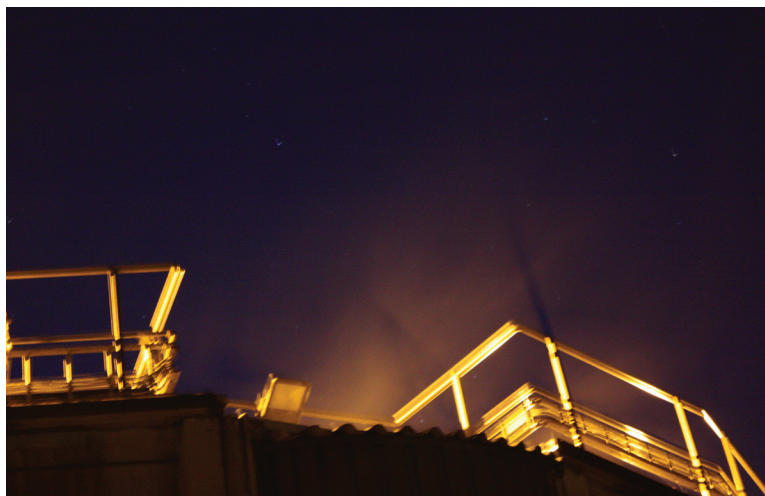
Rejektvattenbehandlingsanläggningen på Norrköpings avloppsreningsverk.
