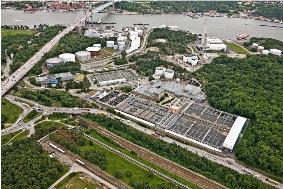
Ryaverket vid Göta älv i Göteborg. Foto: Bergslagsbild AB (2011)
